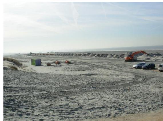
Werkzaamheden op het nieuwe strand bij slag Beukel
