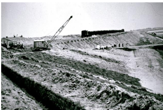
Werkzaamheden bij slag Arentsduin in 1953
